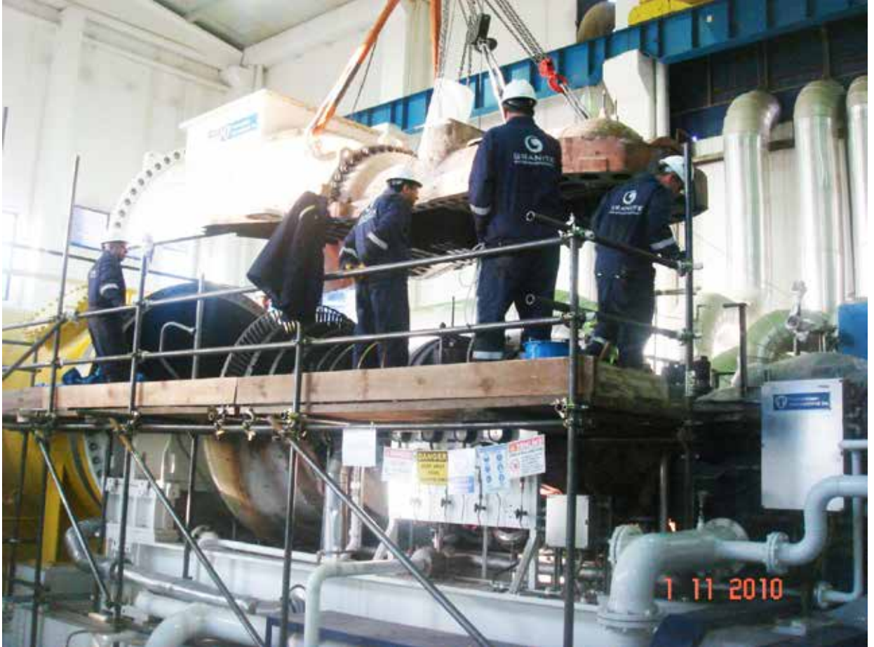
Resim 7 – Buhar türbininin etrafına yapılan ve çalışılabilir onayı verilen iskele
