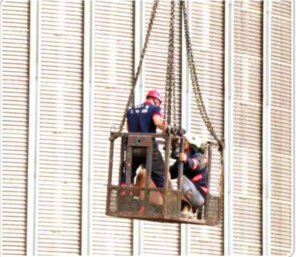
Resim 2- 15/9/2024 Pazar günü OBA makarna fabrikasında patlama ve yangın sonucu ağır yaralanan içinin silodan itfaiye kurtarma ekiplerince indirilmesi (3,4) .
