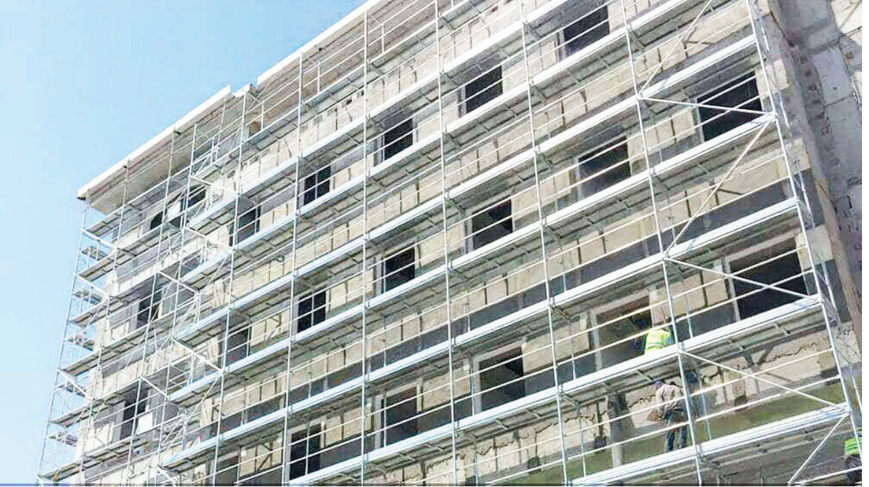
Resim 3- Yönetmelik ve standartlarda istenen iskele örneği
