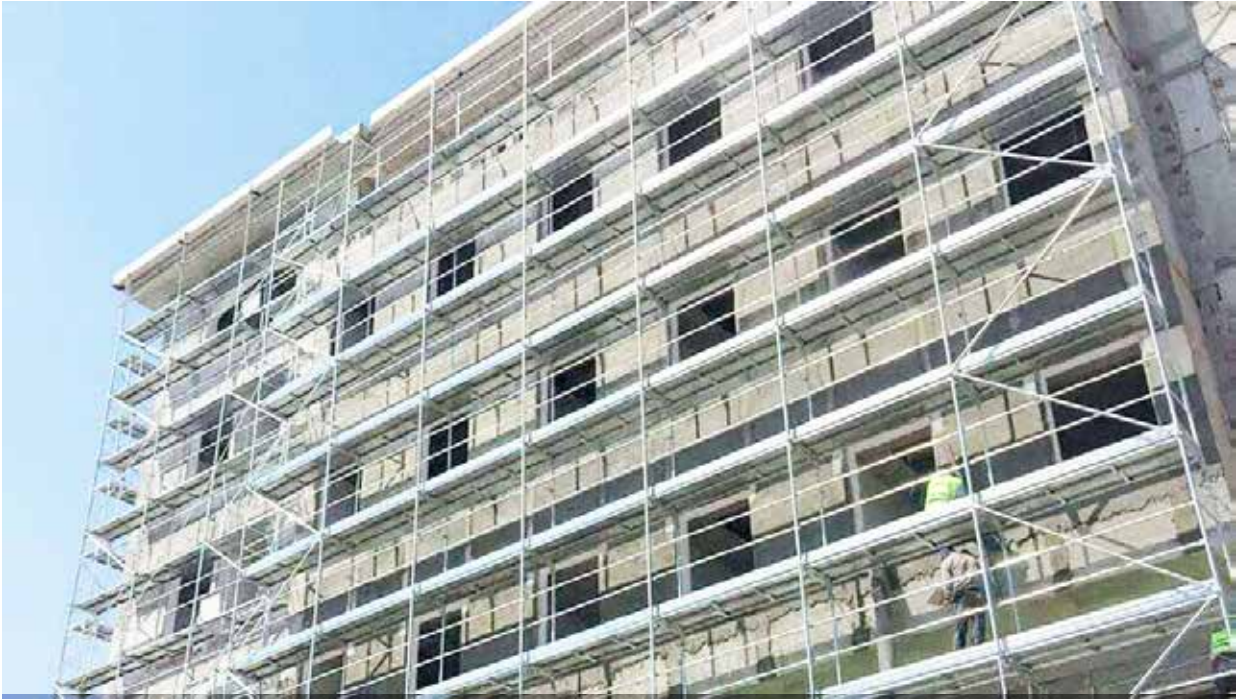
Resim 3- Yönetmelik ve standartlarda istenen iskele örneği
