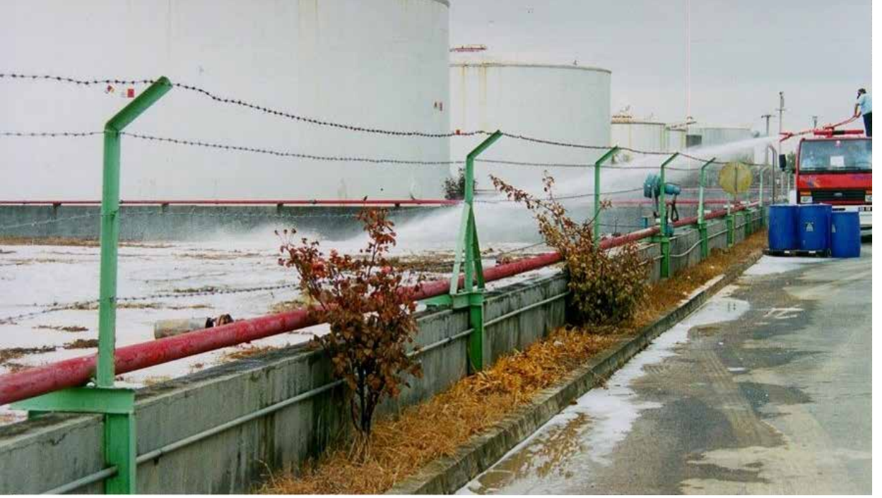
Resim 14- Deprem etkisiyle kırılan borudan ve hasarlı tanktan dökülen, buharı havadan 1,8 kat daha ağır olan zararlı ve tehlikeli kimyasalın üzerine işyeri acil durum (röle) ekipleri ve itfaiye ekiplerince 17/08/1999 günü ve takip eden günlerde yangın söndürme köpüğünün sıkılması.
