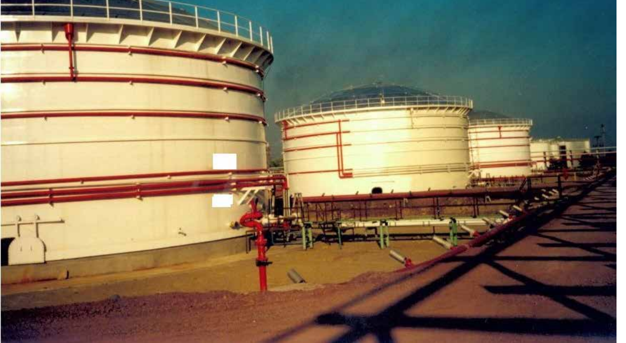
Resim 17- API 620, 650, 653, NFPA 30 gibi iyi mühendislik/depolama uygulamalarına örnekler (17/08/1999 depolamada kimyasalın döküldüğü tank çiftliği!).
