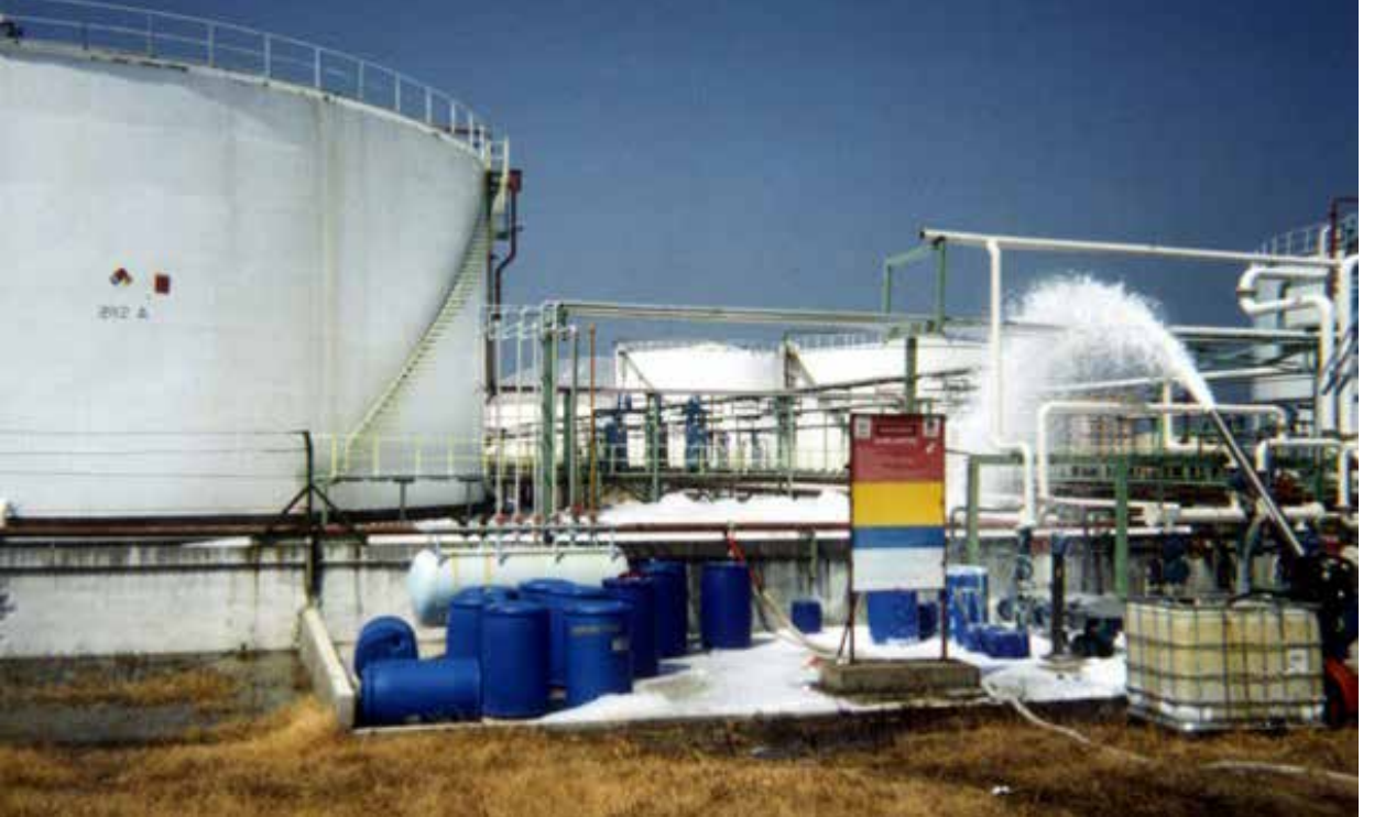
Resim 15- Tankların güvenlik havuzlarındaki zararlı ve tehlikeli kimyasalın, "buharlaşarak çevrede daha büyük tehlike oluşturmaması için" üstü köpükle kapatılmaya çalışılması (19/08/1999 günü ve takip eden birkaç gün içinde).
