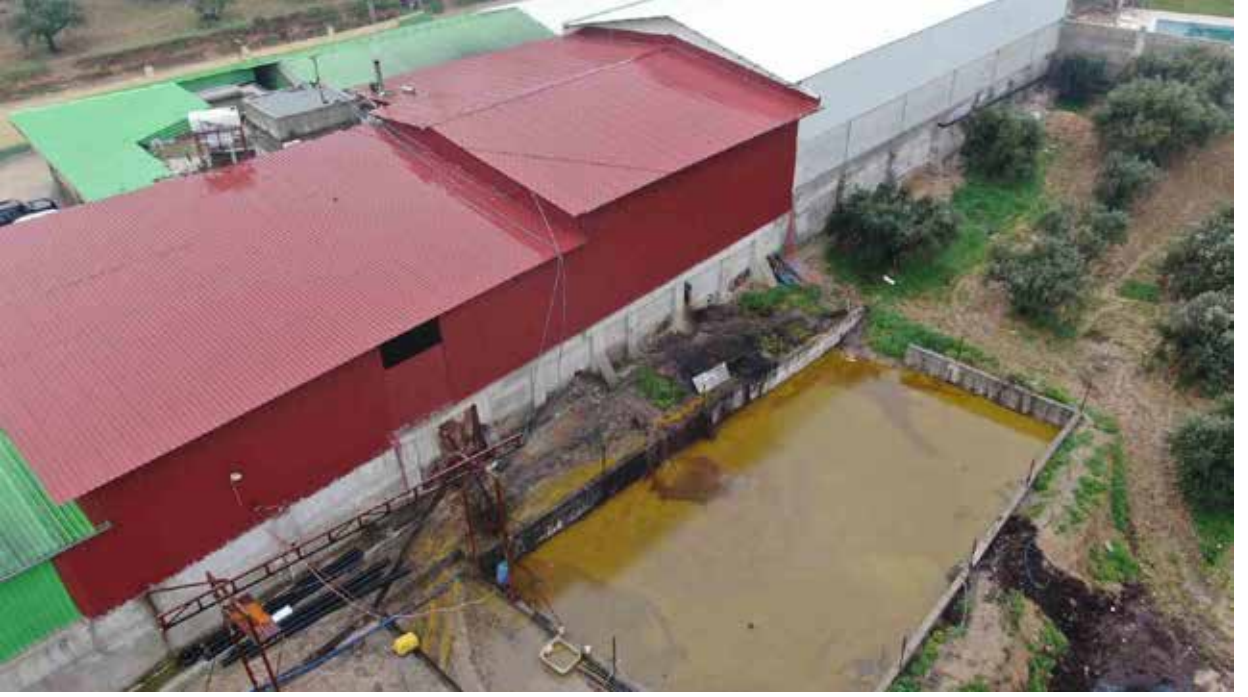
Resim 9- Tankların içinde taşıdığı maddeye ve hacmine uygun güvenlik kabı/havuzu olmadığından çevreye yayılan zeytinyağı (16,17) .
