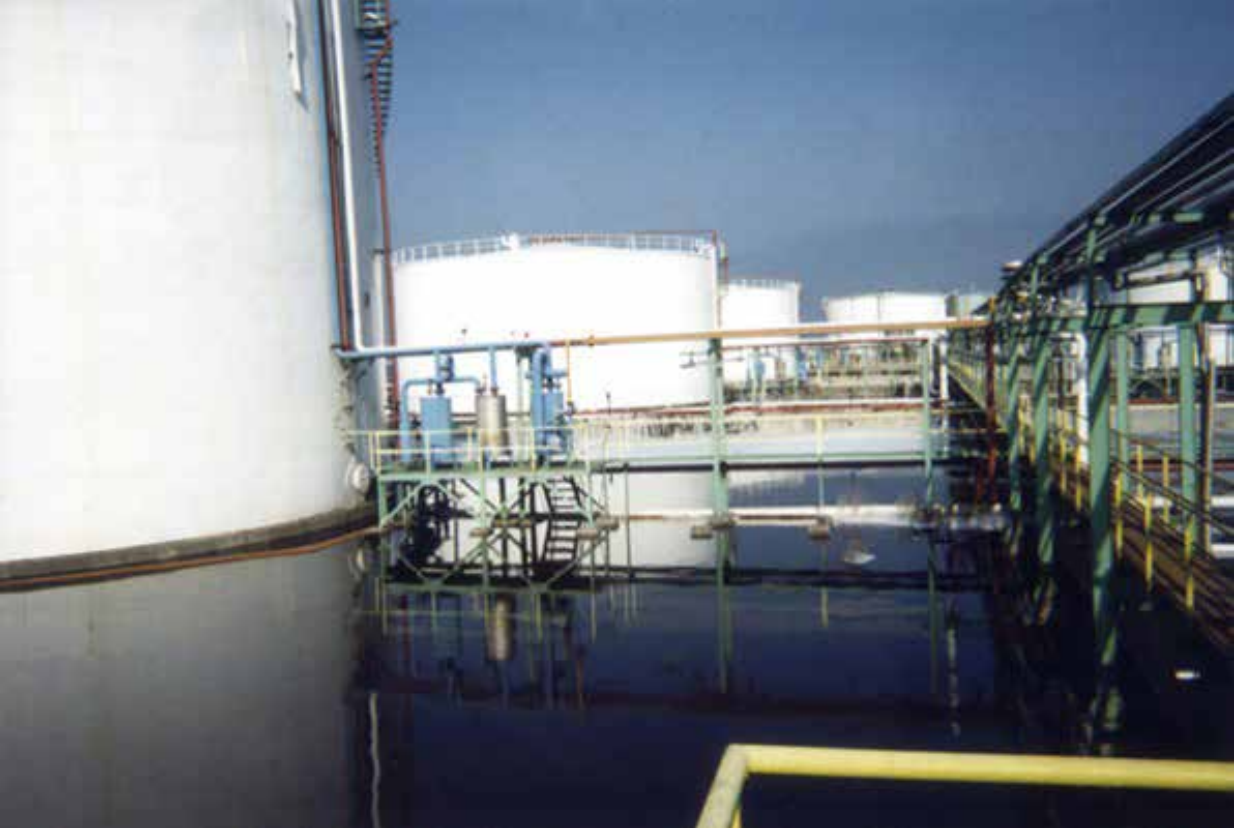
Resim 12- 17/08/1999 günü depolama tanklarından dökülen zararlı ve tehlikeli kimyasal maddenin bir kısmı güvenlik kavuzuna dolmuş.
