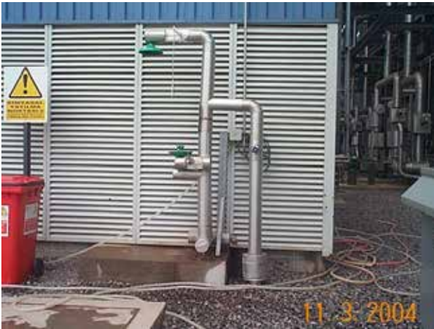
Resim 9, 10 - Sakarya - Adapazarı'nda soğuk ve sıcak havaya koşullarına karşı ısı izolasyonu yapılmış göz duşu ve acil duş sistemi.
