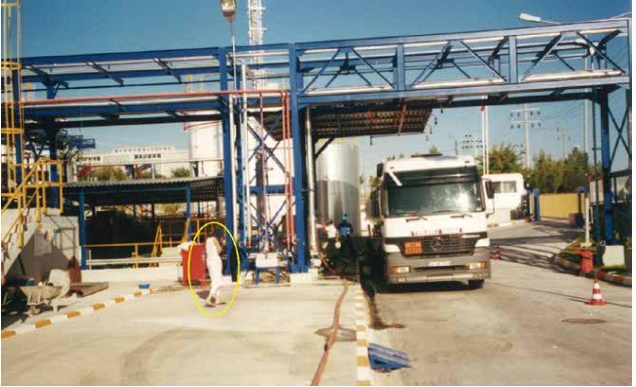
Resim 1 - Rafinerilerden getirdiği naftayı kojenerasyon elektrik santralının depolama tanklarına transfer edilmesi
