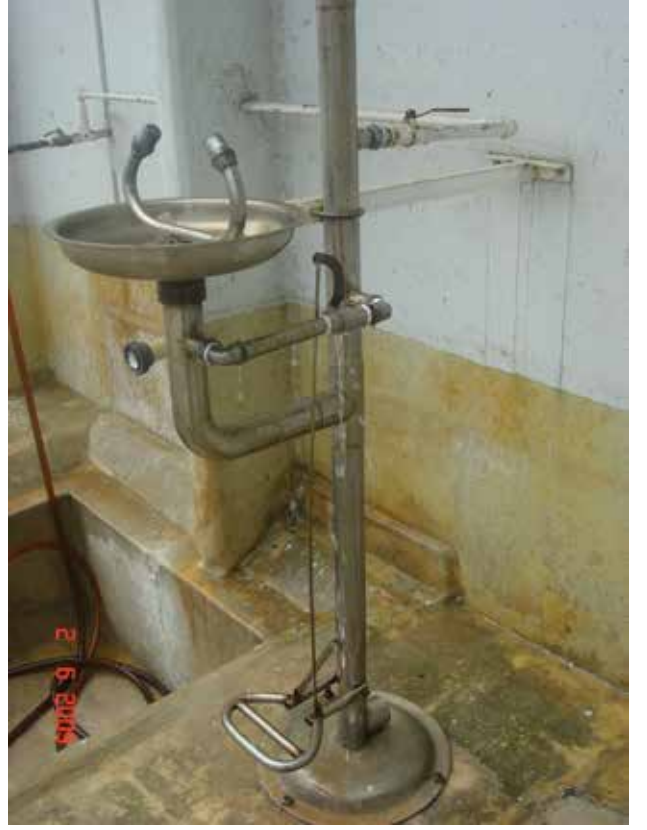
Resim 7, 8 – Uşak ve Bozüyük'te işyerinde göz duşu ve acil duş. Soğuk havada (dondan) patlamış!
