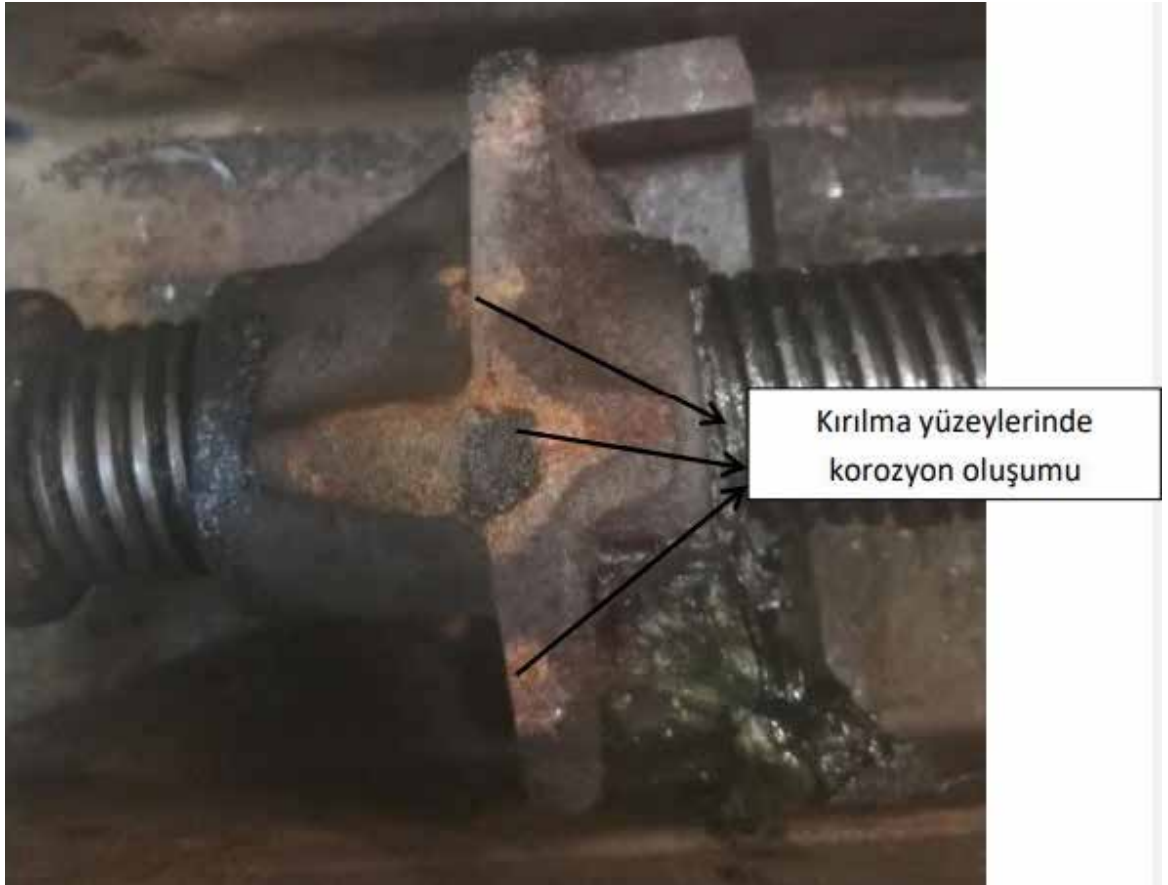
Fotoğraf 9 - Kırılma Yüzeylerinde Korozyon (17)
