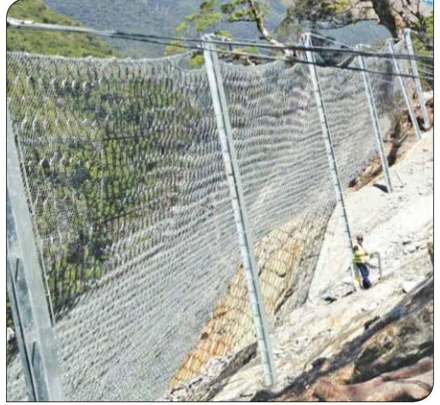
Resim 14- Yamaçtan taş, kaya yuvarlanmasına karşı alınabilecek önlem örneği
