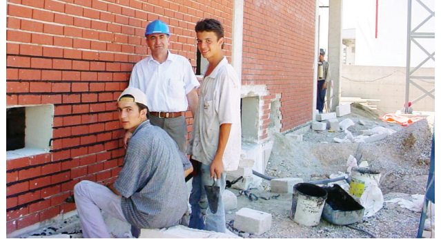
Resim 1 ve 2 – Genç işçiler inşaat işinde derz yapmaktadır.
