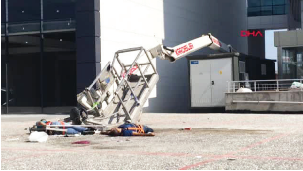
Resim 14 – Vinç sepeti ile birlikte beton zemine düşen iki işçi (35,36,37)
