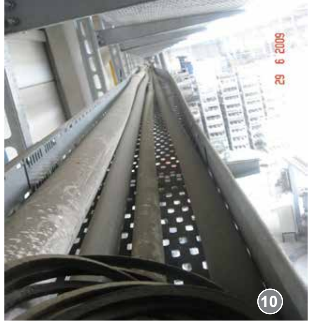
Resim 10 - Akü fabrikasında kablo tavası, hortum ve boruların üzerine biriken tozlar
