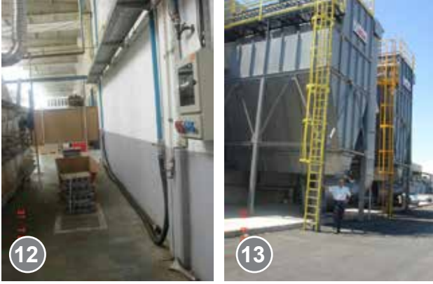
Resim 12, 13 - Çalışma ortamına ve yüzeylere yayılan kurşun oksit tozlarının vakumlu sistem ile toplanıp (emilip) siklonlarda toplanması
