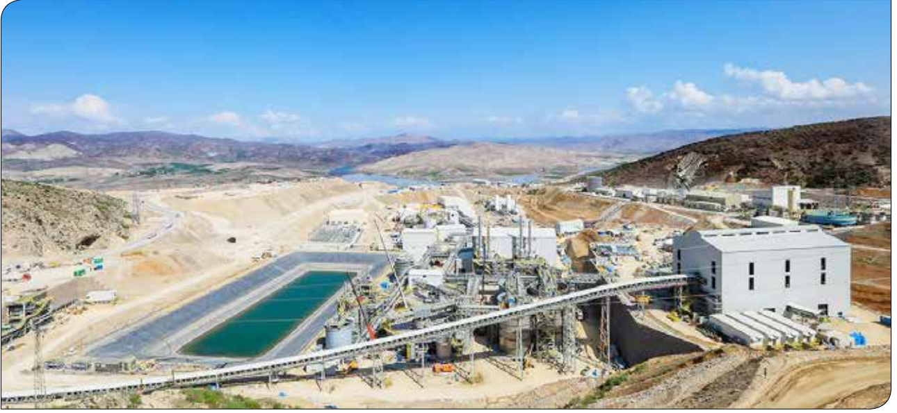
Erzincan'ın İliç İlçesi Yakuplu Köyü yakınlarından Anagold Madencilik İşletmesi
