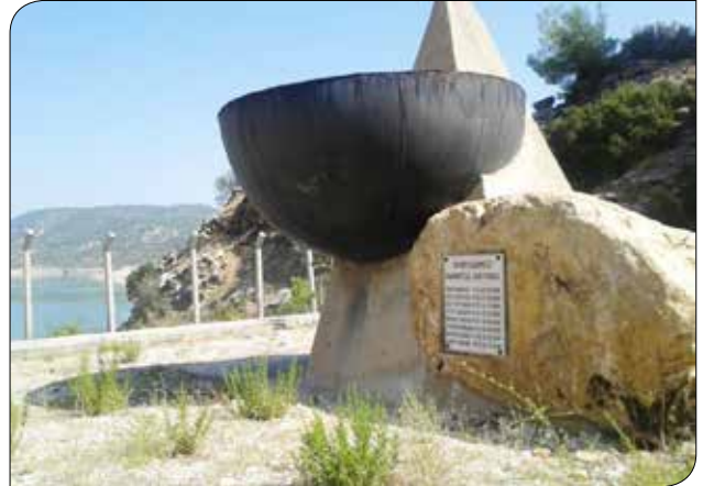
Resim 3: Denizli’de bulunan Adıgüzül Barajı ve Hidroelektrik Santrali
