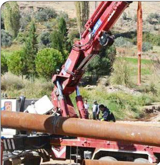
Resim 10 – Boru kaldırırken kopan bez sapan
