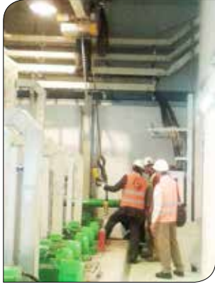
Resim 12, 13 – Yük testi öncesi mekanik ve elektrik aksamının gözle kontrolü ve ağırlık testinin uygulanması
