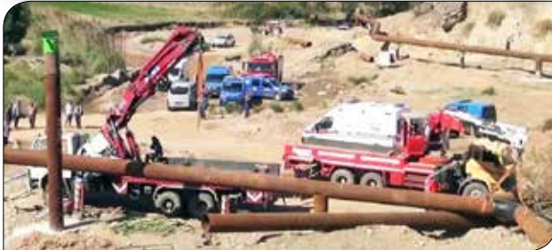
Resim 9 – Bez ve zincir sapanlarla kaldırılmaya çalışılan borular
