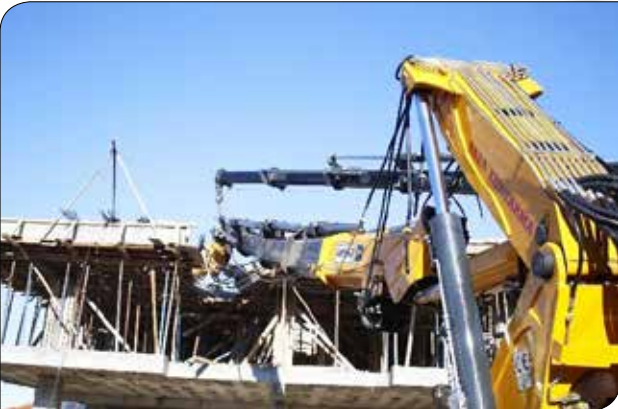
Resim 4 – Vincin bomunun kırılması
