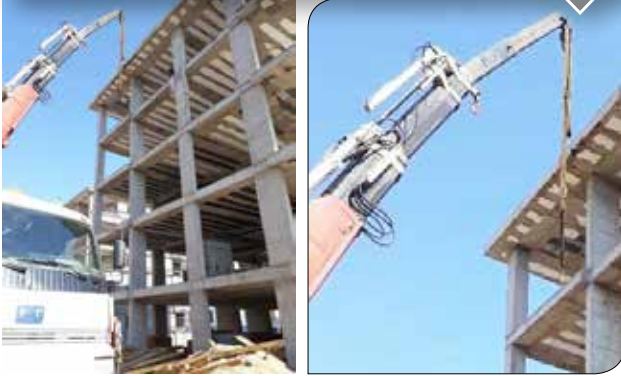
Resim 7 ve 8 – Vinçten kopan oldukça yıpranmış bez sapanın görüntüsü
