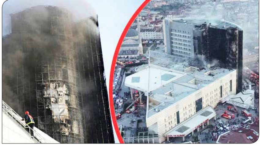
İstanbul Gaziosmanpaşa'daki Taksim Eğitim ve Araştırma Hastanesi'nde çıkan yangın (Nisan 2018)
