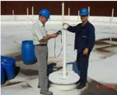
Resim 7, 8: Yüzer tavanlı içi boşaltılmış nafta tankının iç görünüşü ve yüzer tavan üzerinden tank içerisinde havalandırma borusundan gaz ölçümü
