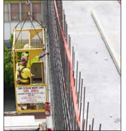
Resim 9 : İnşaatta vince asılı bir sepet içerisinde çalışma
