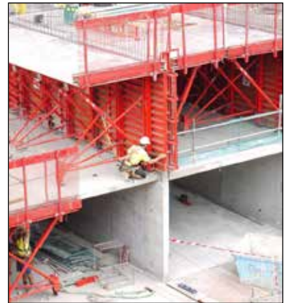
Resim 10: Bina inşaatında çift halatlı (lanyardlı) emniyet kemeri ile çalışma Bu örnekler çoğaltılabilir.
