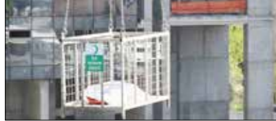
Resim 5: İnşaat sepeti ile 15’inci kattan düşen işçinin kaza yerinden alınması
