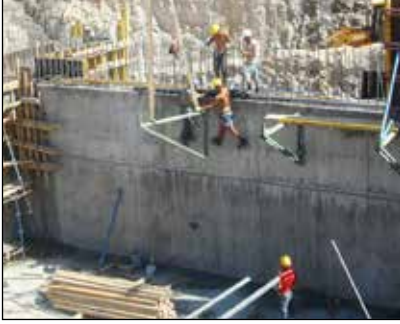
Resim 1: Sanayi tesisi inşaat işçileri
