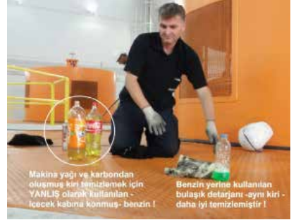
[Bir Hidro Elektrik Santralinde – bakım sırasında – türbin platformunun temizlenmesi; Benzin yerine mutfak deterjanı daha iyi temizlemiştir]
