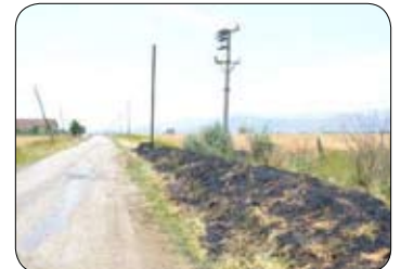
Resim 8(a,b) – Leyleğin konduğu direk ve yanması sonucu neden olduğu yangın yeri (14,15)
