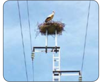
Resim 15 (a,b) - Yapay leylek (yuva) platformları (15,35,36,37) .
