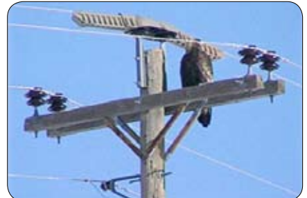
Resim 17 - Merkezdeki fazın üzeri uzun plastik bir malzeme ile kaplama (39) .
