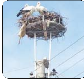
Resim 15 (a,b) - Yapay leylek (yuva) platformları (15,35,36,37) .
