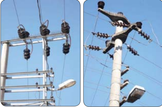
Resim 19 (a,b) - Elektrik direkleri üzerinde kuş konmaz dikenler (İzmit-30.08.2015)
