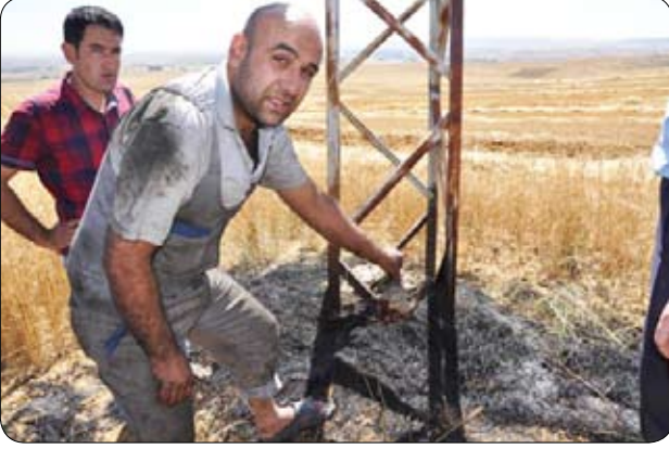
Resim 13(a,b) – Yozgat'ta elektrik iletim hattı ve kuşların (karga) neden olduğu yangın (22,23,24)
