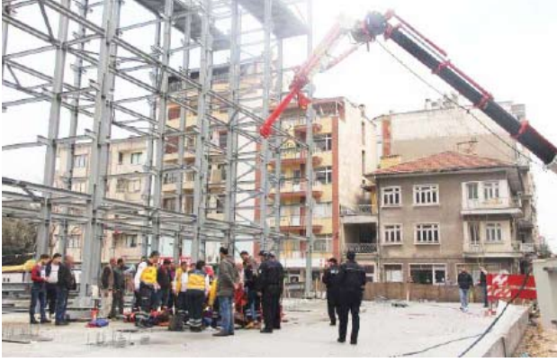
Resim 5 – Vinçten çıkan / düşen sepet ve yaralılar (16,17,18)
