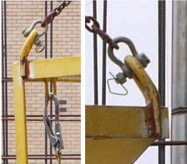
Resim 8 a, b- Vinç sepetinin uygun bağlanması ve emniyet kemeri takılabilirliği 2260 kg'a dayanıklı ankraj/bağlantı noktası.
