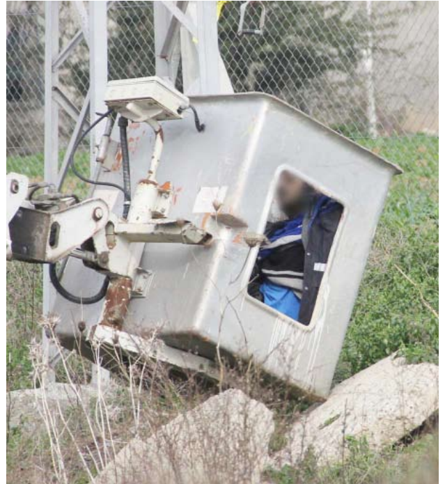
Resim 4 – Vinç sepetinde elektrik akımına kapılan görevli (13,14,15)
