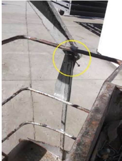
Resim 7b- Vinç sepetinin gevşeyen bağlantı yerlerinin tuturulması (Denetim sonucu görülen)
