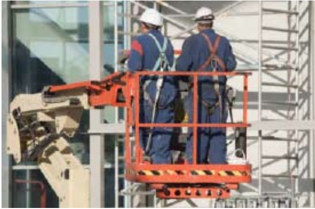
Resim 10 – Çalışma sepeti ve emniyet kemerinin uygun kullanılması (22)
