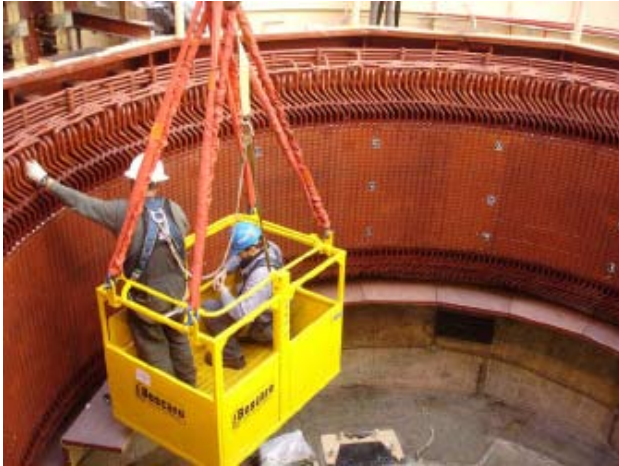
Resim 11- Vinç sepetinin ve emniyet kemerinin uygun kullanılması.
