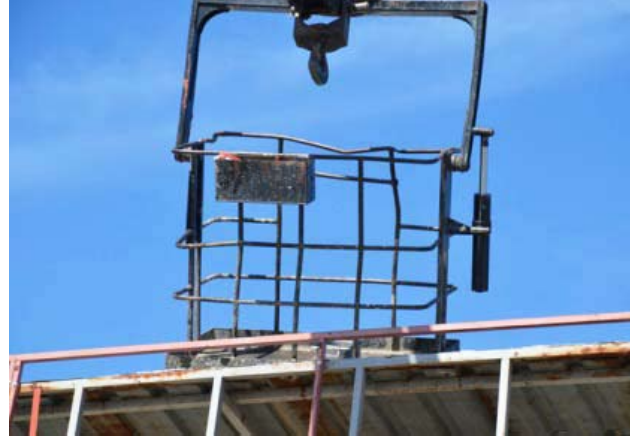
Resim 3- Vinç sepetinin durumu ve sepet kasasında –olasılıkla- kullanılmayan bel tipi emniyet kemeri (10,11,12)
