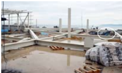
Resim 11: Düşen çelik konstrüksiyon (30,31)
