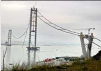
Resim 1: İzmit Körfez Geçiş Köprüsü (5)
