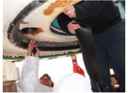
Resim 2 : Kriko ile kaldırılan tonlarca ağırlığında HES mekanizmasının altında çalışanlar
