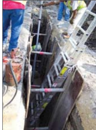
Resim 10 – Su borusu montajında alüminyum hidrolik payandaların kullanılması (17)
