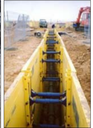
Resim 11 – Kanalizasyon çalışmalarında payanda kullanma örneği (21)
