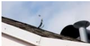
Kalıcı (sabit) Çatı Ankrajı [13]
