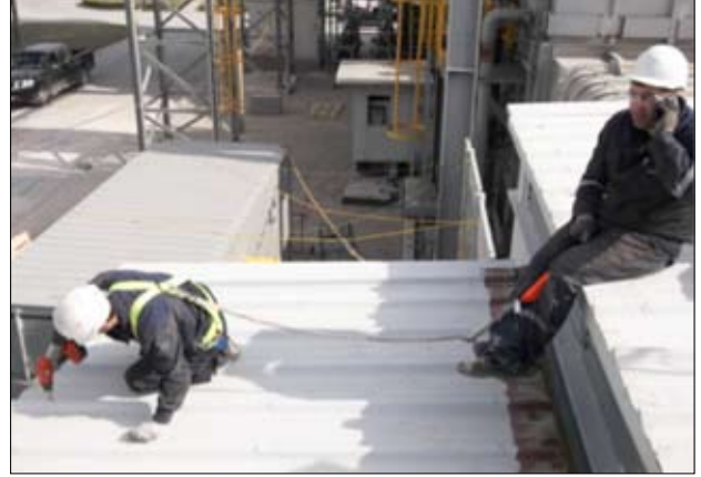
Resim 2: Bir makine odasının çatının sökülmesi
