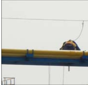
Resim 7: Tek bacaklı lanyard ile yaşam hattına bağlı
