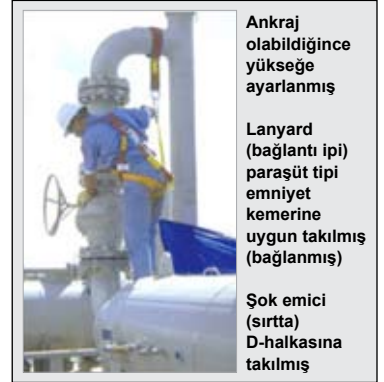
Resim 12: Ankraj noktası bağlantı elemanları [15]
