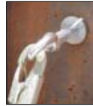
Resim 19: Kirişli Kavrama Ankray Halkaları : Bu aksesuarlar (parçalar) çelik bölümler (üyeler) üzerine cıvata deliklerinden monte edilebilir. Bunlar her yöne 2268 kg (5000 lb) dayanacak şekildedir [14] .
