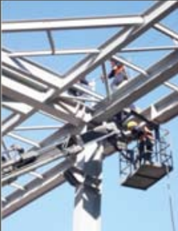
Resim 6: Tek bacaklı lanyard ile yaşam hattına bağlı
