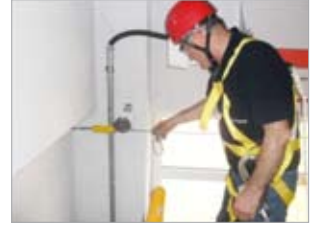
Resim 10: Ankraj noktalarının kontrolü
