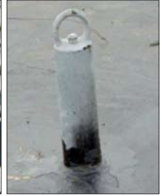
Resim 18: Sabit (kalıcı) ankrajlar [14]
