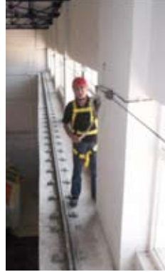
Resim 11: Tavan altı vinç güzergahına uygulanmış yatay yaşam (ankraj) hattı
