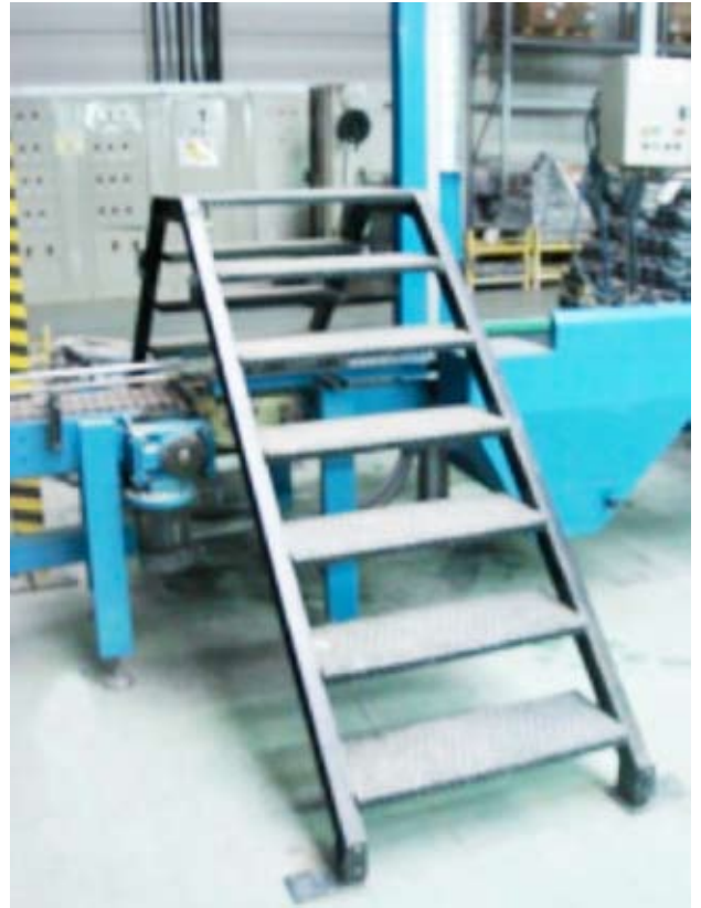
Resim 2- İşyerinde korkuluğu ve trabzanı olmayan bir merdiven.
