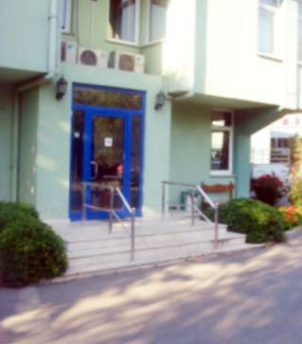
Resim 4 – Fabrika ofis binası girişi. Ülkemizde (Resim 4) 2 veya 3 basamakla çıkılan ve merdivende korkuluk ve trabzanı olan bir işyeri.
