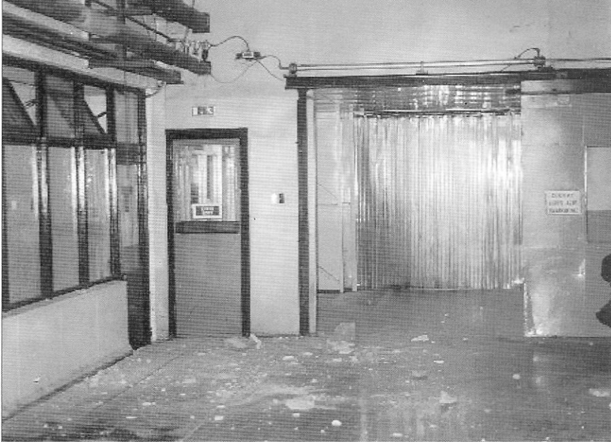
17 Ağustos 1999 depremi sonrası bir işyerinde acil çıkış kapısı.
