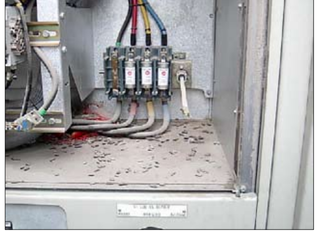
Doğal gaz türbininde fare veya sıçan'ın girdiği yer
