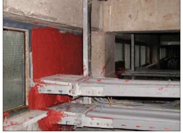
Kablo geçiş yerlerinde yapılan yangın izolasyonu, aynı zamanda kedi ve haşerelerin (sıçan, fare, yılan vb.) giriş noktalarını da kapatmıştır.
