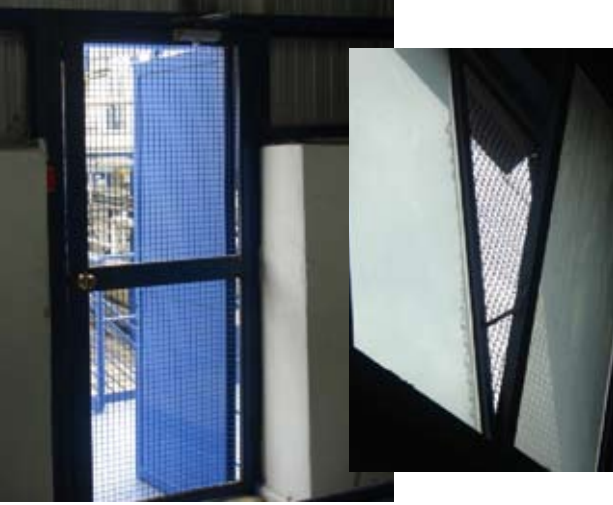
(Güvercinlerin girip çıkmaması için işyerinin açık kalabilen pencere ve kapılarına tel kafesi düzenek yapılan bir işyeri)
