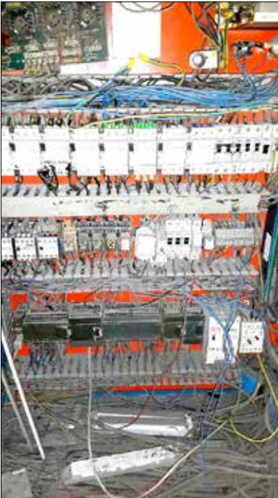
Resim 4: İçinde metal (demir) tozu birikmiş panel.
