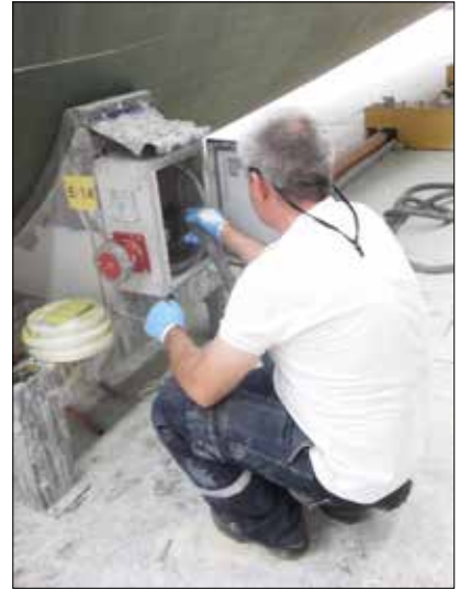
Resim 9: Bir elektrik kutusunun temizlenmesi.
