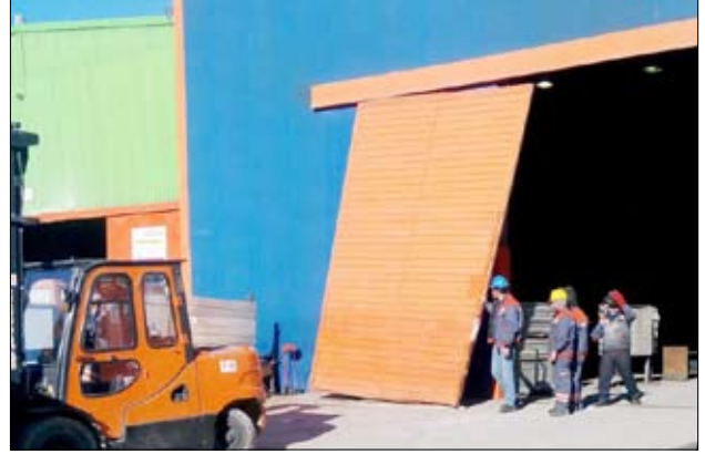
Resim 5- Raylı demir kapının düşmesine ramak kala.
