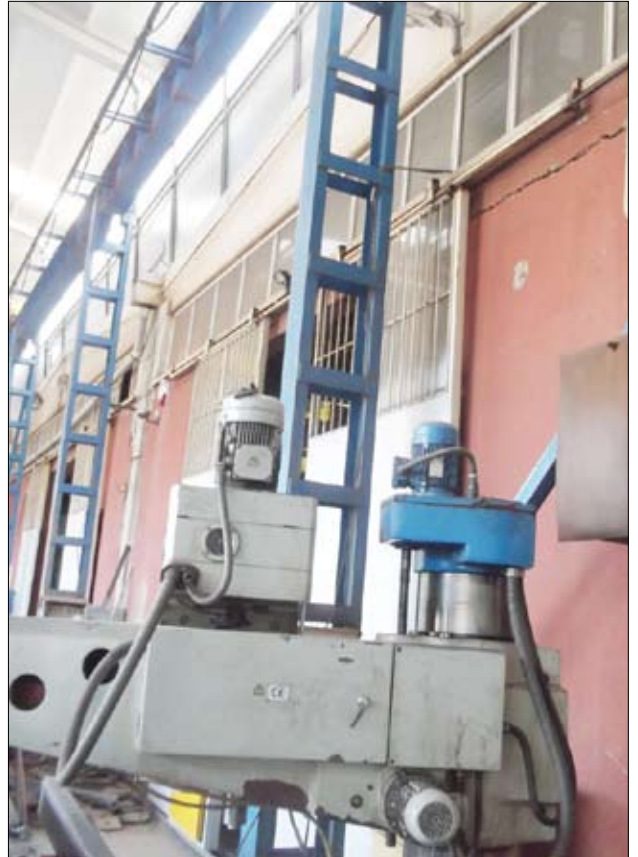
Resim 10- Raydan çıkmayı ve devrilmeyi önleyici güvenlik sistemi örneği.
