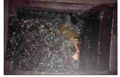
Resim 8: Kuşadası Atıksu Tesisi Izgara önünde işçi (23) .
