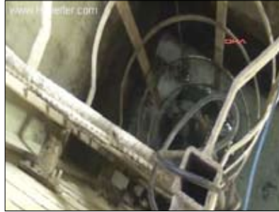
Resim 6 : Milas, Güllük Beldesi Atıksu Terfi İstasyonu Tırmanma Merdiveni (20) .
