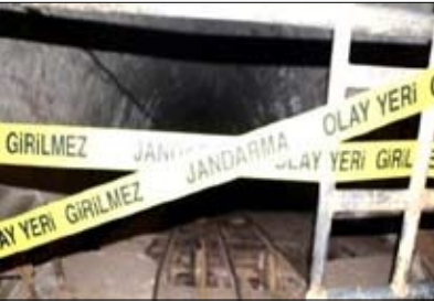
Resim 4: Milas İlçesi Güllük Beldesi Atıksu Terfi İstasyonu (15) .
