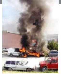
Resim 10: Patlayan trafonun altına park edilmiş araçların yanması
