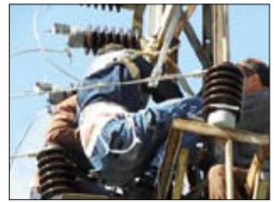
Resim 5- Elektrik direğinde çarpılan V.A. kurtarma çalışması
