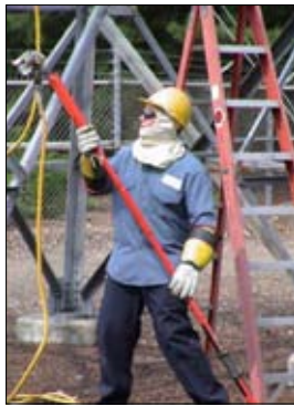
Resim 26- Uygun KKD'li elektrikçi
