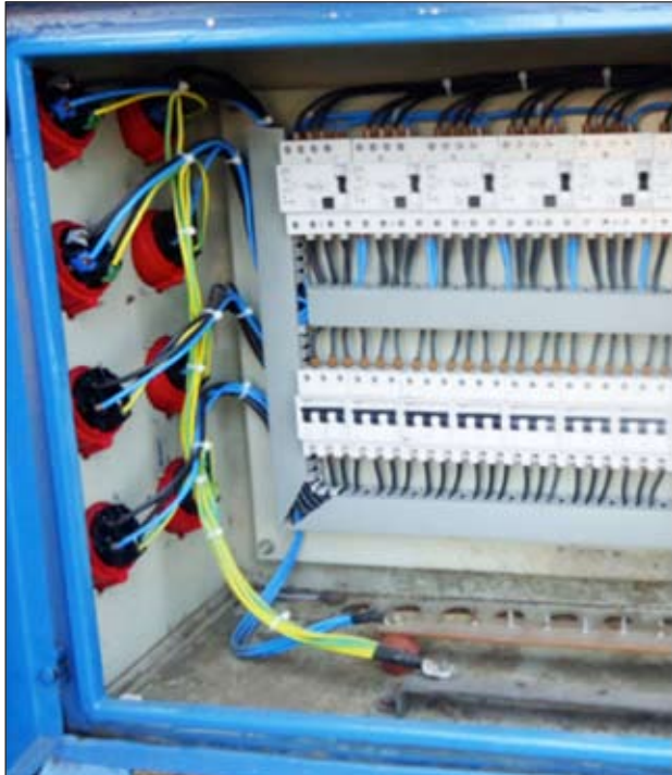
Şekil 4: Panoda K.A. Rölesi Uygulaması
