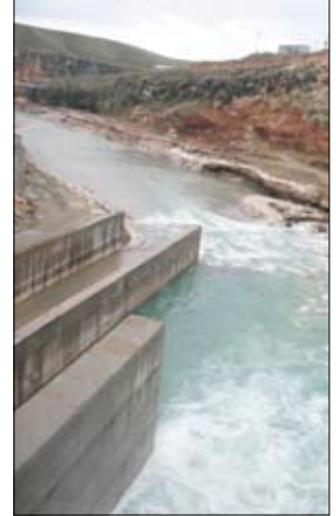
Resim 6 - Radyal kapak çok az açıldıktan 5 dakika sonrası
