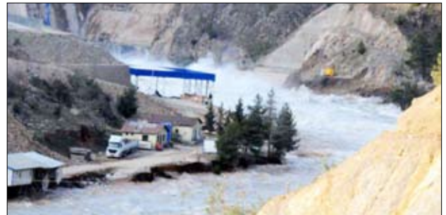
Resim 2 – Dip savak kapağının patlaması sonrası(8)
