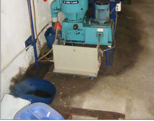
Resim 2a- Çevre kirliliği ve kayarak düşmeye neden olabilecek bir yağ pompasının olduğu yer.
