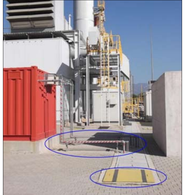
Şekil 1c- Sürekli iyileştirme; rögar kapaklarının görünür-lüğünü arttırmak için sarı siyah renklere boyanması.
