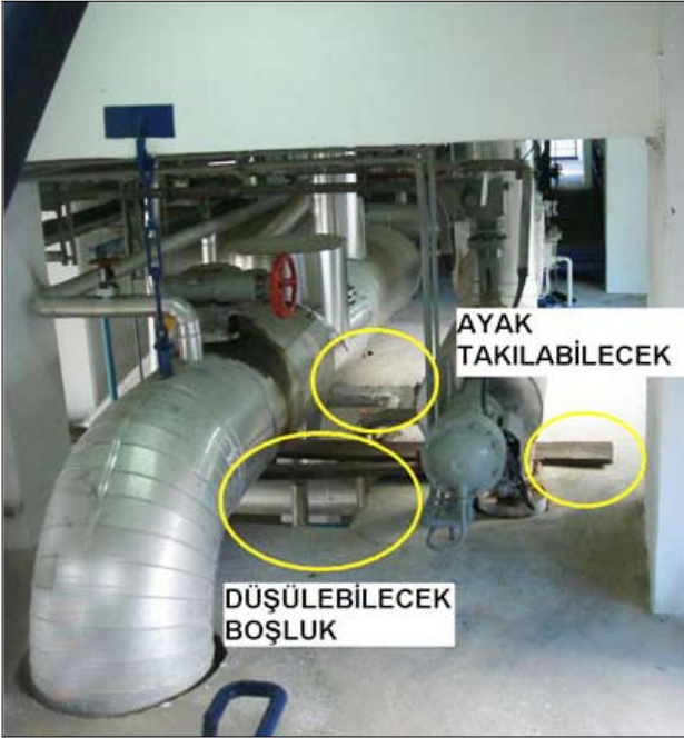
Şekil 3a – Kızgın buhar hattının altında (4-5 m aşağıya) düşülebilecek açıklık
