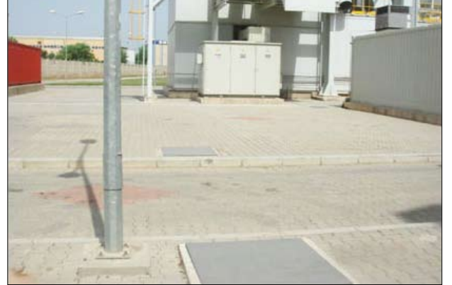
Resim 1 b- İyileştirme: Takılıp düşmeyi en aza indirebilecek şekilde beton kapakların yerine çelik-sac kapaklar yapılması.
