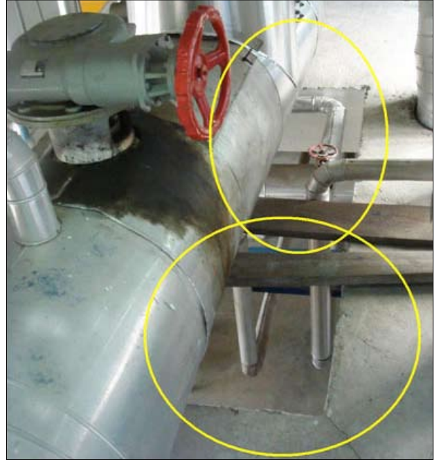
Şekil 3 b- Kızgın buhar vanasında bir operasyon yapılırken operatörün aşağıya düşebileceği açıklık.
